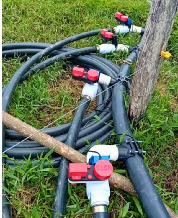
Figura 26. Módulo de control de las electroválvulas
